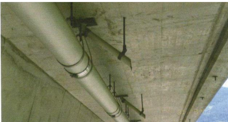
Sabirna odvodna cijev i cijev za odvod procjednih voda
