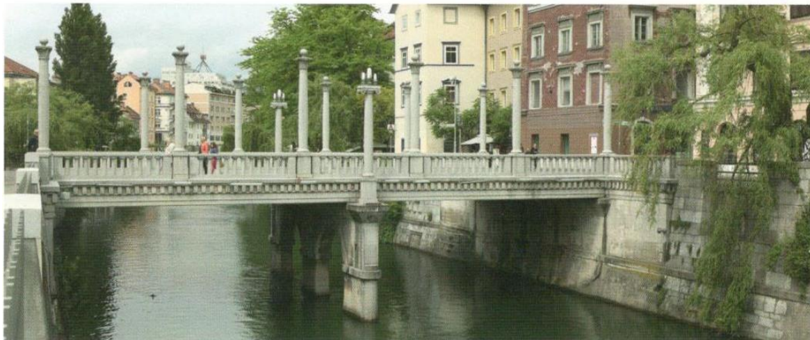
Stubovi za rasvjetu na pješačkom mostu preko Ljubljanice, početak XX vijeka
